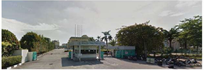
KAO Prai, Penang, Malaysia
